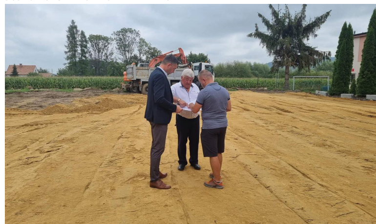
TRWAJĄ PRACE PRZY MODERNIZACJI BOISKA PRZY ZESPOLE SZKOLNO - PRZEDSZKOLNYM W WIELKIEJ WSI.
