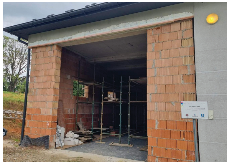
BUDOWA GARAŻU PRZY WIEJSKIM DOMU KULTURY W GRABNIE
