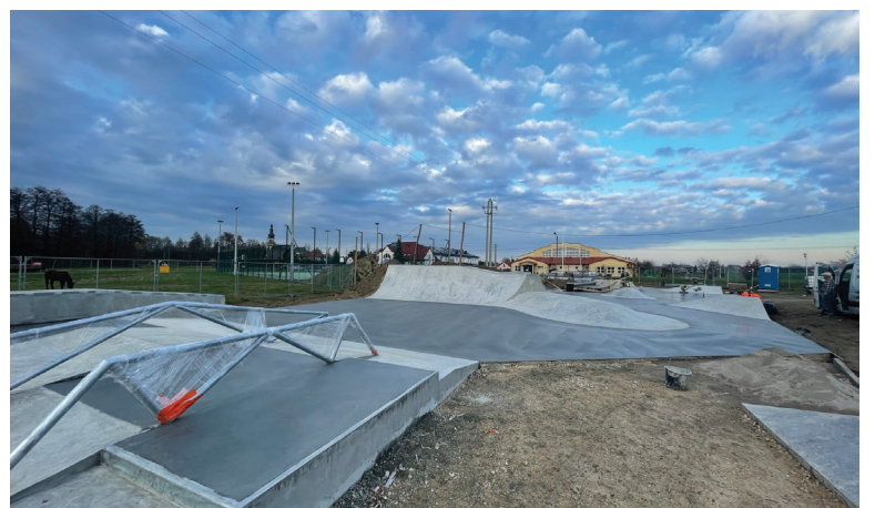
BUDOWA SKATEPARKU W WOJNICZU PRZY UL. ROLNICZEJ
