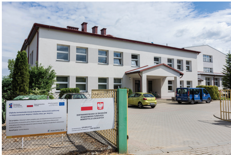
TERMOMODERNIZACJA BUDYNKU SZKOŁY PODSTAWOWEJ W WOJNICZU
