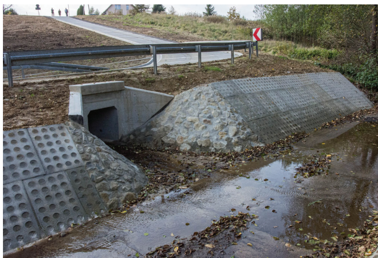
NOWA DROGA W GRABNIE WRAZ Z PRZEPUSTEM
