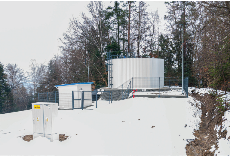
ZAKOŃCZENIE BUDOWY SIECI WODOCIĄGOWEJ W MIEJSCOWOŚCIACH: MILÓWKA, SUKMANIE, OLSZYN, WIELKA WIEŚ ORAZ W WOJNICZU
