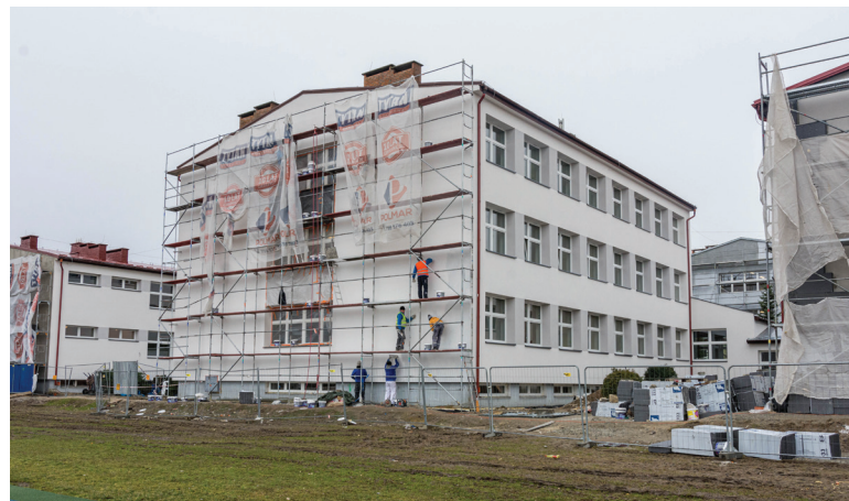
TERMOMODERNIZACJA SZKOŁY PODSTAWOWEJ W WOJNICZU
