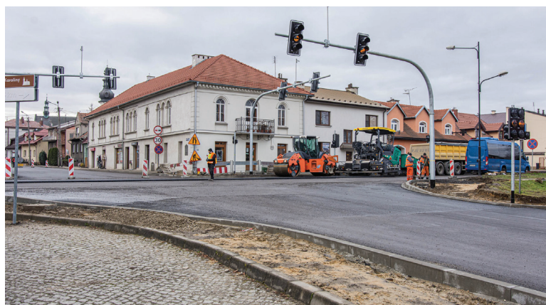
PRACE REMONTOWE W CIĄGU ULIC WARSZAWSKA – JAGIELLOŃSKA
