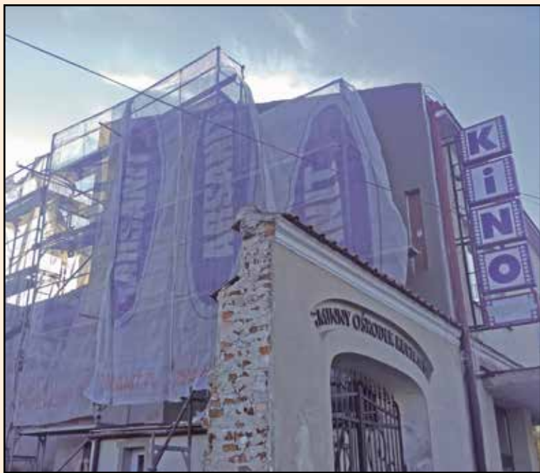
Remont elewacji budynku kina
